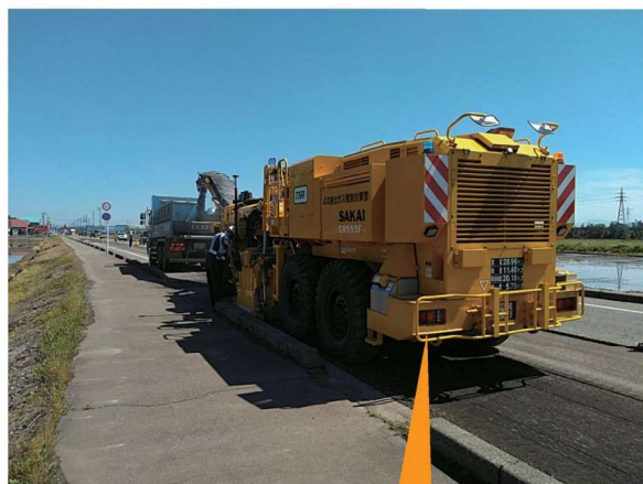
路面切削機にて 傷んだ舗装部分5cmを取除きます
